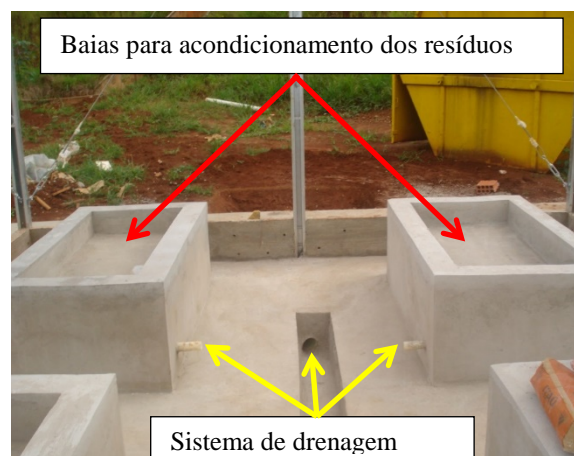
Figura 2 – Instalações para secagem e classificação dos resíduos dos gradeamentos grosseiro e fino
